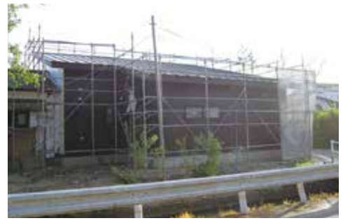
▲屋根や外壁はもちろん、施工はほとんど自社での工事。実習生もたくさん関わりました
