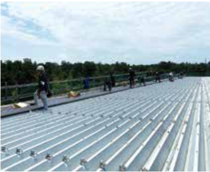
▲当社創設以来最大の75m長尺折版屋根カバー工事の様子
