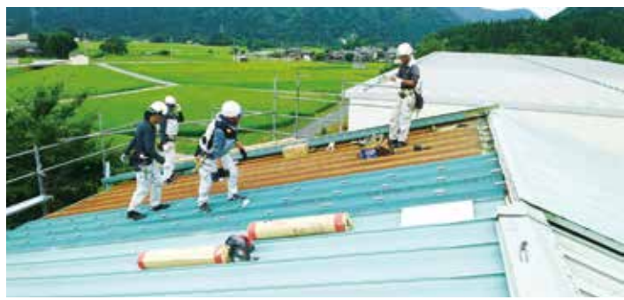
▲真夏の太陽が激しく照りつける屋根上での作業は過酷を極めます
