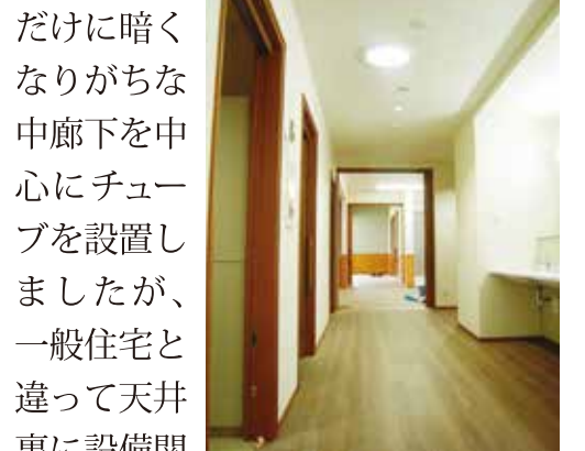
▲施設内部/手洗い場前の中廊下にスカイライトチューブを設置
