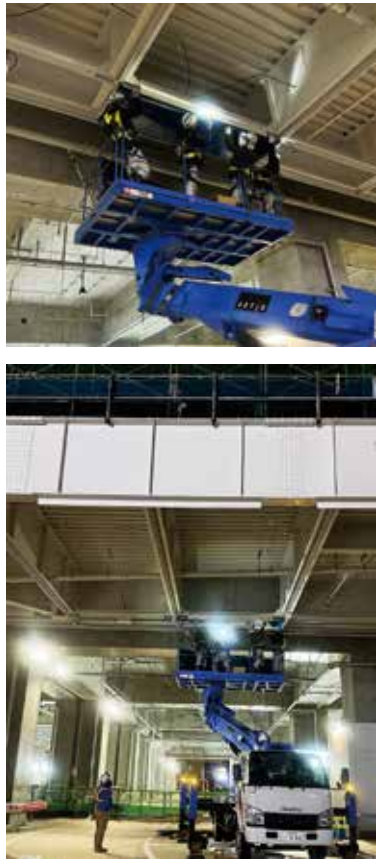
左:完成目前のペデストリアンデッキ 右:高所作業車を使っての夜間工事の様子
