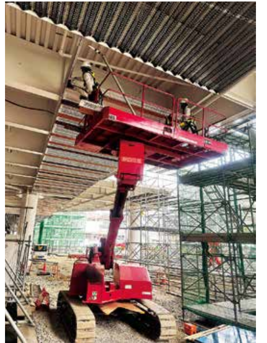
▲通行止めの必要のない場所はもちろん日中の工事でも対応
