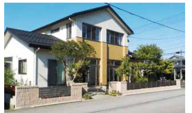
▲完成したK邸のフェンス付きブロック塀(高さ1.0m、長さ18.4m)
