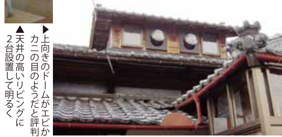
▲上向きのドームがエッジがカニの目のようにだと評判。天井の高いリビングに2台設置して明るく。
