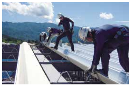
▲大型物件の長尺折板屋根の施工の様子
